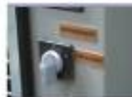
Botão de consumo , para acionamento da bomba de circulação de água e motor de refrigeração.
